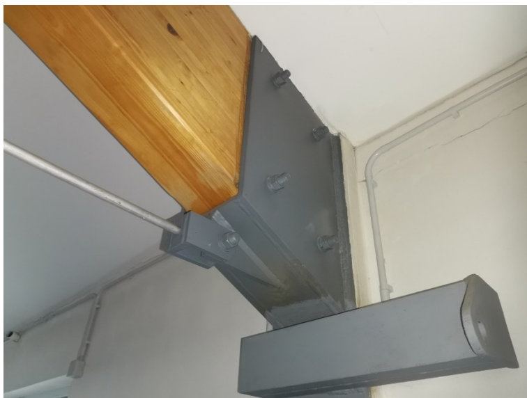
detail uložení vazníku na ocelový sloup
